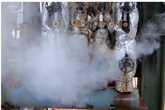
Odvádzanie odpadovej pary do atmosféry je plytvanie tepelnou energiou
